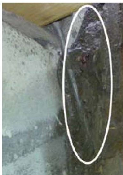
Gjutspill kortsluter elastiskt upplagd trappa mot trapphusplan.
