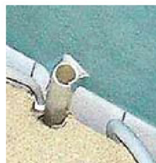
"Extra" kablar kläms mellan flytande golv och vägg.
